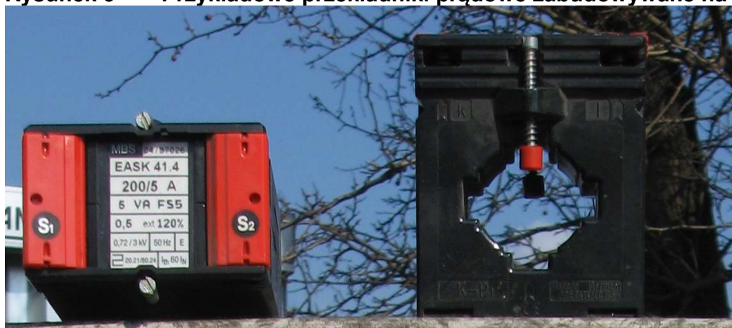
Rysunek 3 Przykładowe przekładniki prądowe zabudowywane na stacji.
